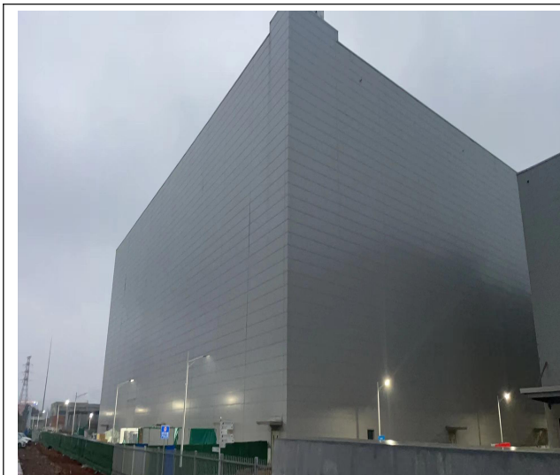
项目北侧 E29 栋
