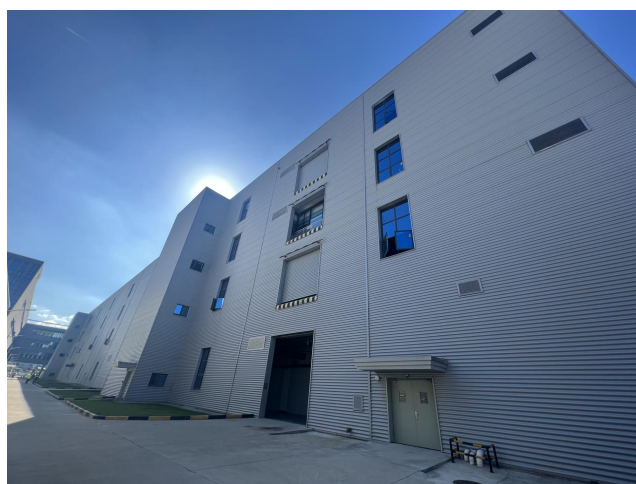
项目西侧 E21 栋
