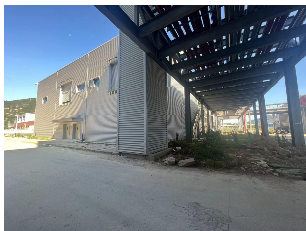
项目厂区南侧污水处理站
